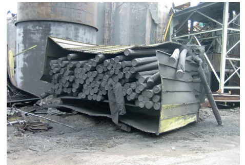
Staubfilter nach Verpuffung, Foto: Dr.-Ing. Kai Steffens
