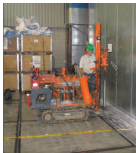
Abb.: Rammkernsondierung innerhalb eines Gebäudes
