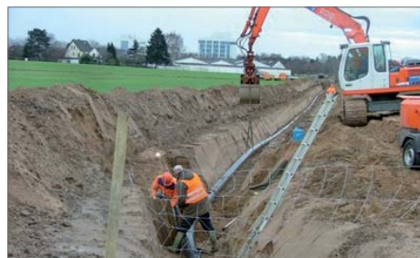
Verlegung der CO-Pipeline in mindestens 1,40 m Tiefe
