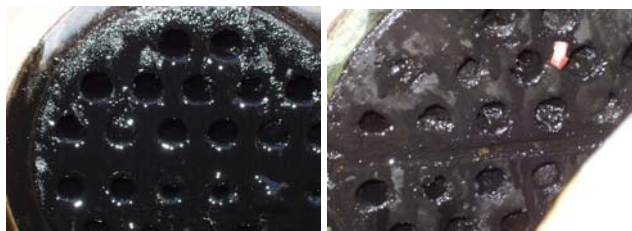
Rohrbündelwärmetauscher nach Versuchsbetrieb mit Pulsation
