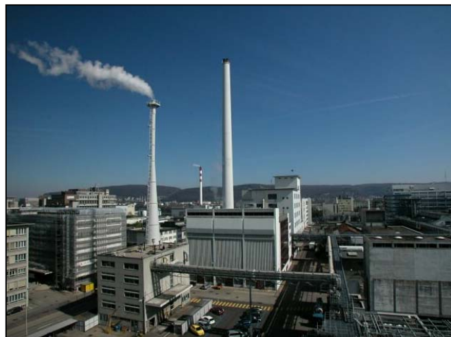
Blick auf die bestehenden Verbrennungsanlagen
